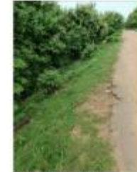
Talus aval de la digue
