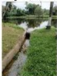
Barrage 1 avec son déversoir en bois
