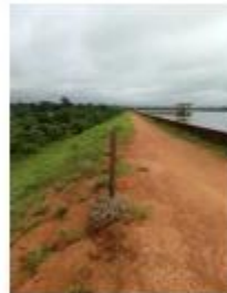
Crête et le talus aval
