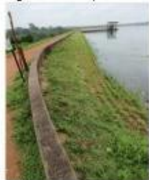
Talus amont de la digue
