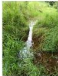
Canal d'alimentation du barrage 2
