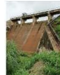
Evacuateur de crue du barrage
