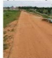
Crête de la digue
