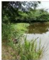
Amont du barrage 2 envahi par les végétaux boueux
