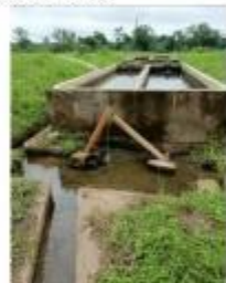
Canal de rejet des eaux vers l'aval
