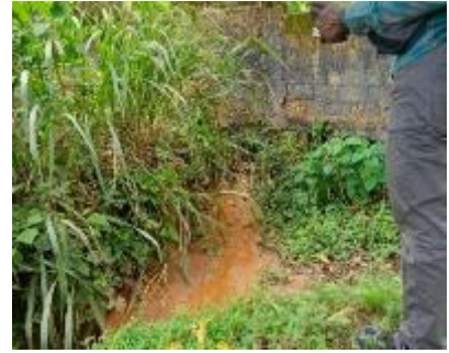
Photo 18 : Point d'entrée d'eaux de ruissellement sur le site de la station d'alevinage
