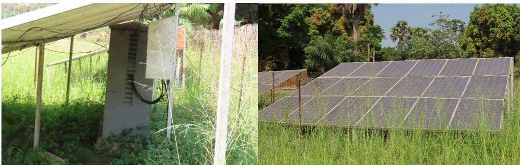
Photo 9: Vue des plaques et de la batterie de l'énergie solaire
